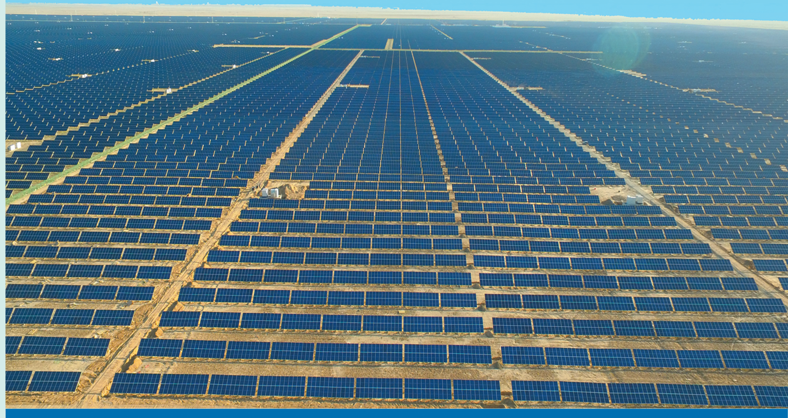
凯升光伏木垒光伏园区100MWp光伏发电项目
